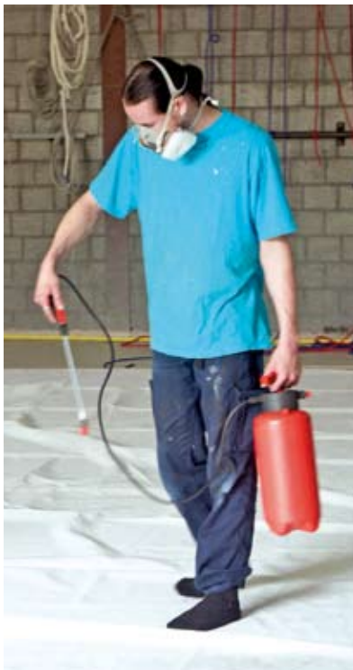
Das Nano-Coating wird von Hand aufgesprüht, eine Gartenspritze reicht völlig aus.
